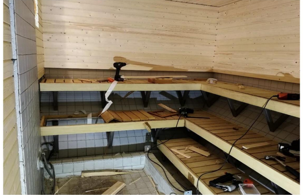
Tänä kesänä huoltotöihin kuuluu mm. ison puolen pikkusaunojen paneelointi sekä kiukaiden takaisen seinän muuraus ja uudelleen laatoitus.
